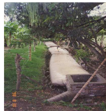
Digesteur de 10 m 3 au Vietnam
